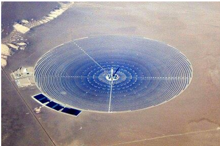
Nhiệt điện mặt trời CSP
